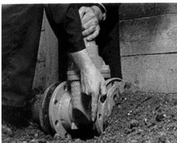
Užmauname flanšus 0102 ir įstatome į vietą
